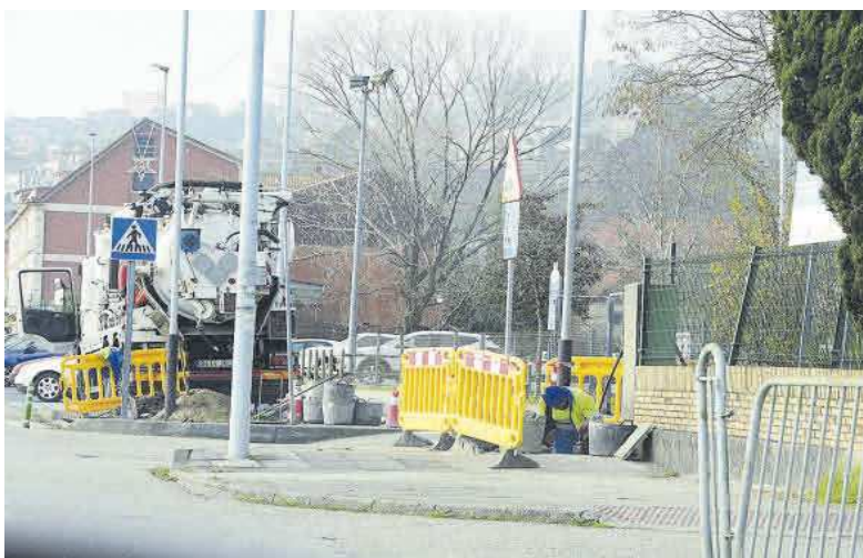
Trabajo, este viernes, de sustitución de la conducción en una acera de la PO-551. | G.N.
