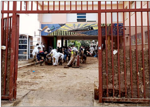
Trabajos de limpieza en un colegio tras el paso de la DANA. EE
