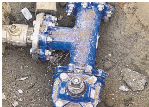
Una de las nuevas conexiones para evitar cortes de agua. | FdV
